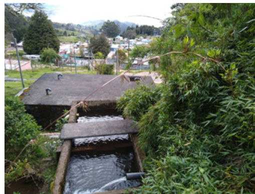
Fotografía 5: acueducto veredal, sector Las Violetas
