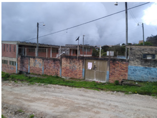
Fotografía 6: Antigua estructura de la Escuela Las Violetas
